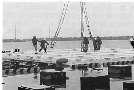
原子炉室一括吊り上げ用吊り金具
