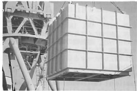
極低レベルタンクの撤去
